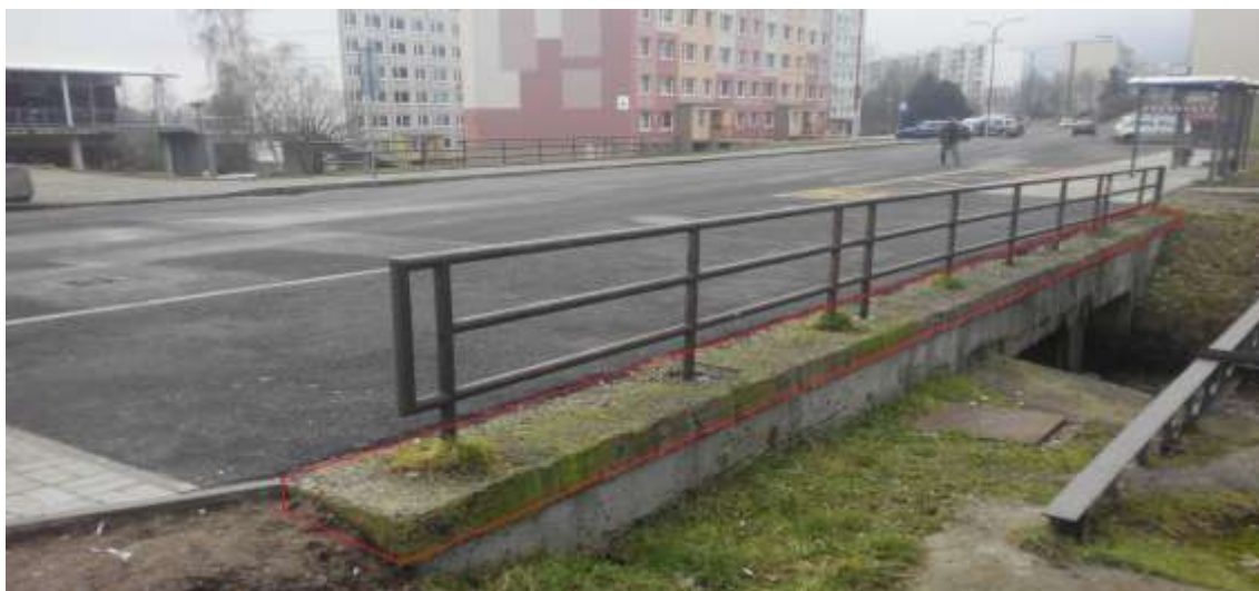
Obr.č.1 – pohled na most s vyznačenou degradovanou římsou
