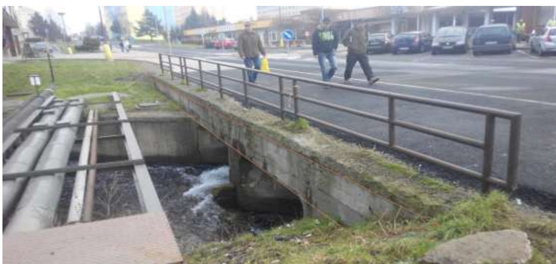
Obr. č.3 - pohled na most s vyznačenou degradovanou poprsní zdí
