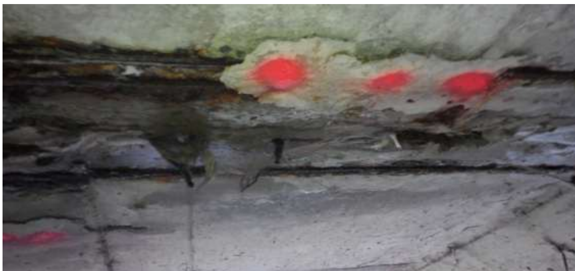
Obr.č.2.- korodující výztuž v tunelu mostu
