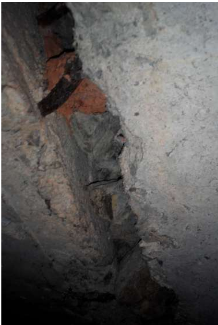
Obr.č.4 - spáry mezi prefabrikáty
